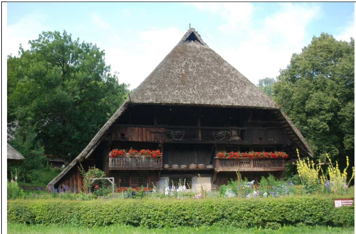
Gutach, casa típica de la Selva Negra, Foto © Ana
