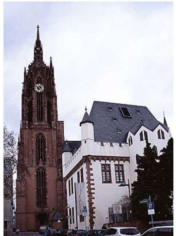
Dom St. Bartholomäus y Leinwandhaus
