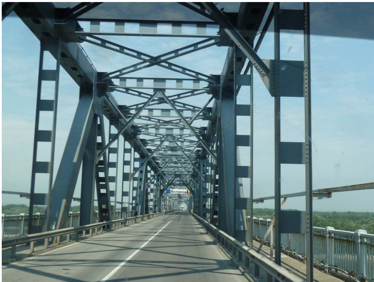
Puente sobre el Danubio
